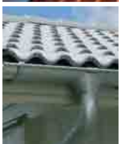
Silverfärgade hängrännor och stuprör
