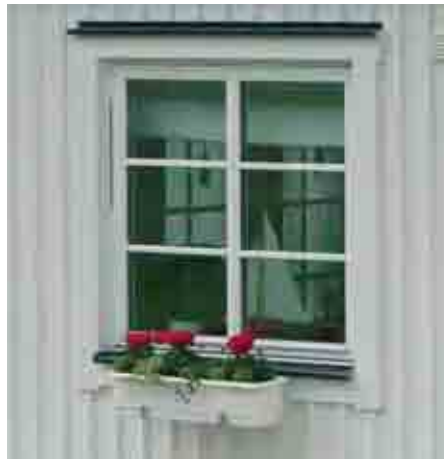
Till höger visas en horisontal fast genomgående post och ovan en fast genomgående vertikal mittpost.
